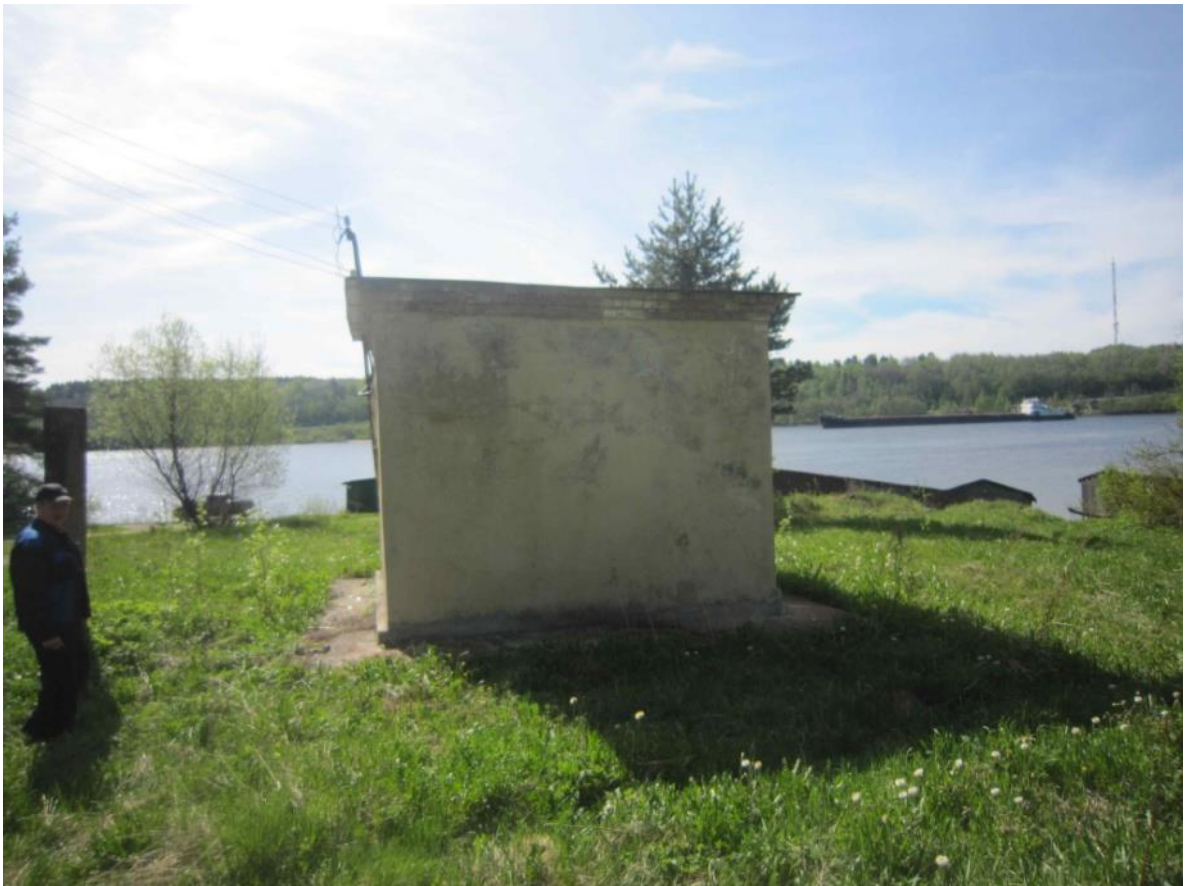
Рисунок.10. Внешний вид павильона скважины №4 (ул. Лисицыной д.28).
