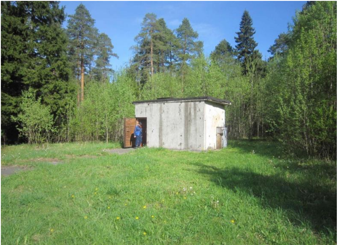
Рисунок. 14. Внешний вид павильона скважины №6 (ул. Новая д.16 б).
