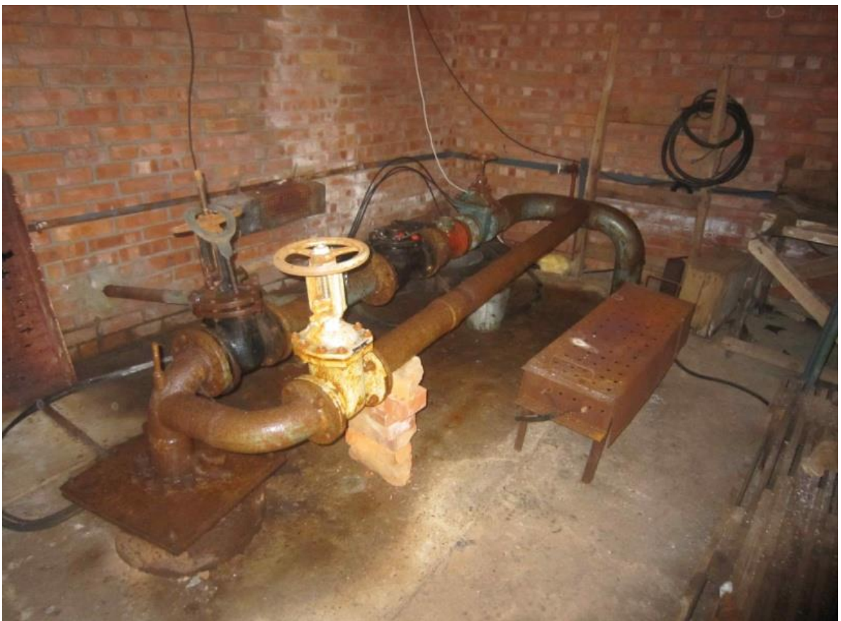
Рисунок. 15. Помещение павильона арт. скважины №6 (ул. Новая д.16 б).
