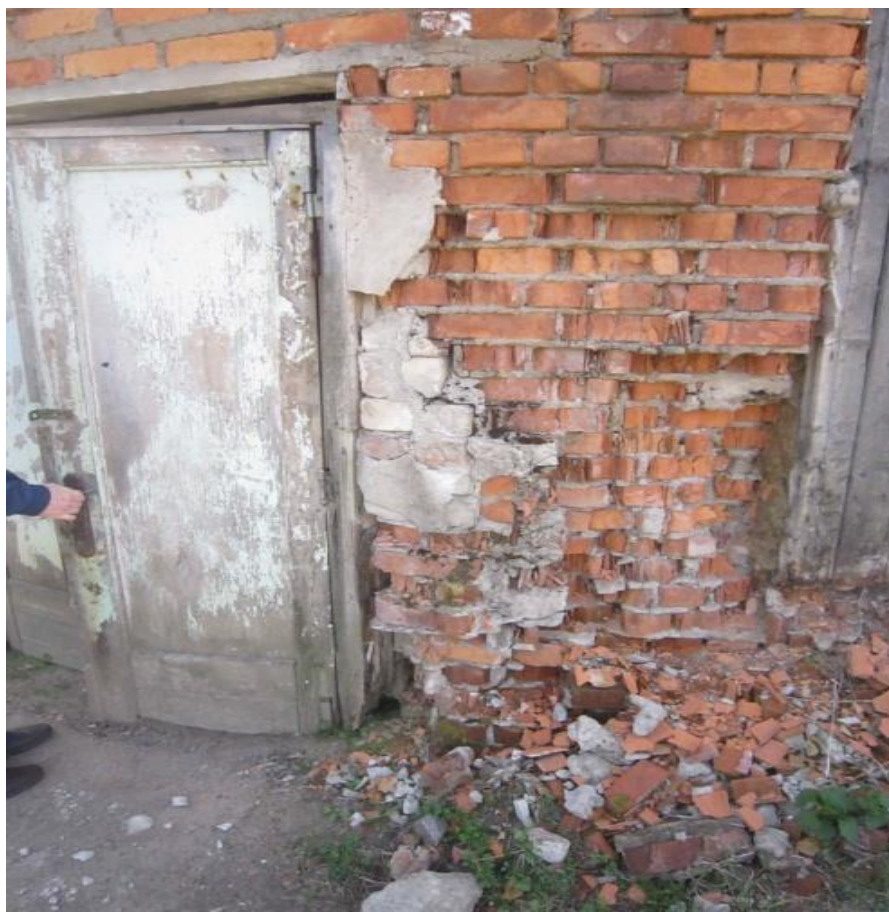
Рисунок 15. Внешний вид здания КНС №2.
