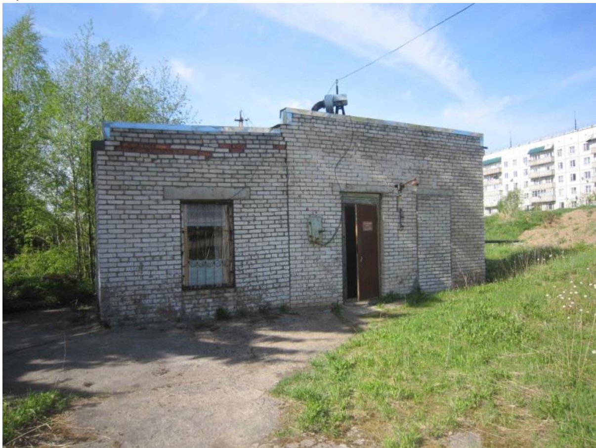
Рисунок 18. Внешний вид здания КНС №1.
