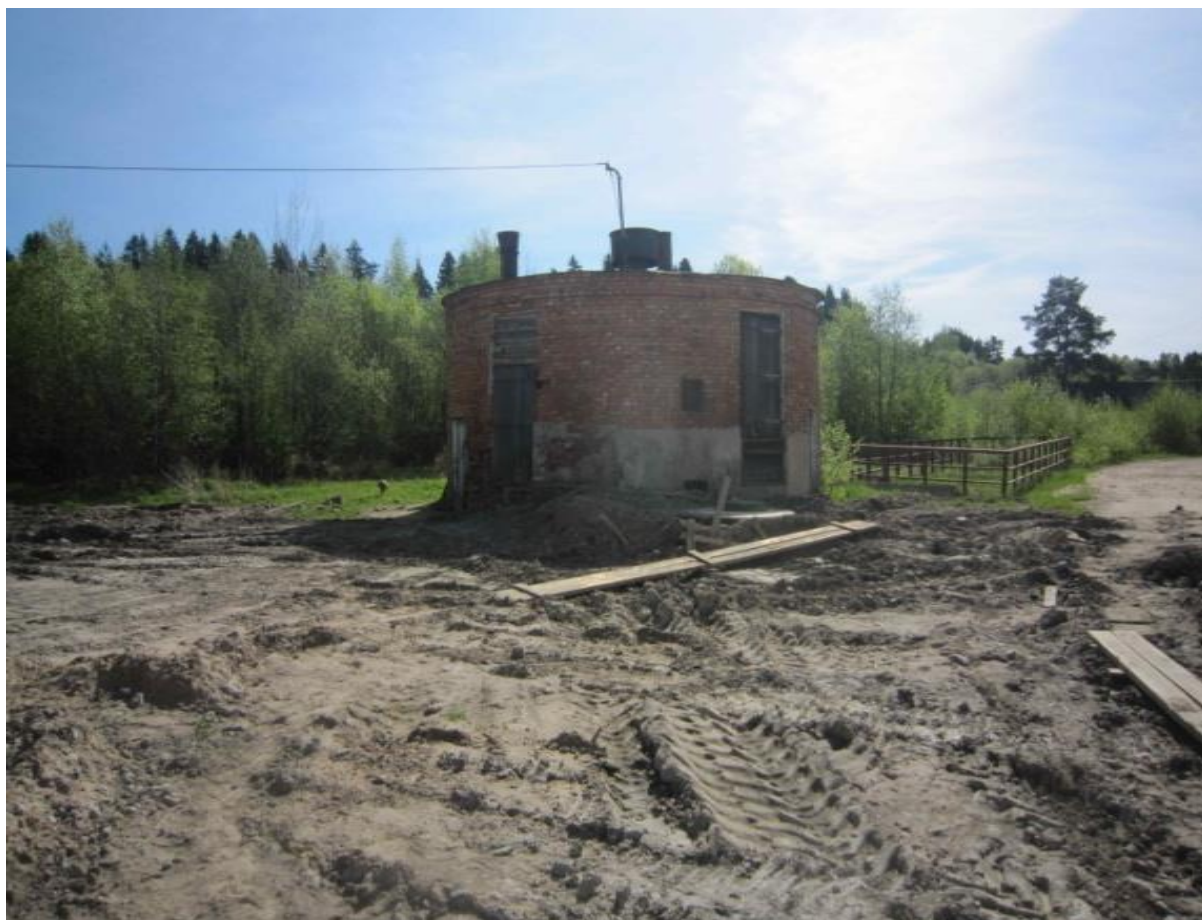
Рисунок 14. Внешний вид здания КНС №2.
